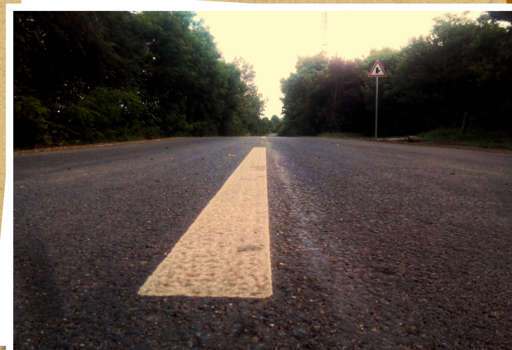
1940-ben épült bekötő út felújítása 2020
