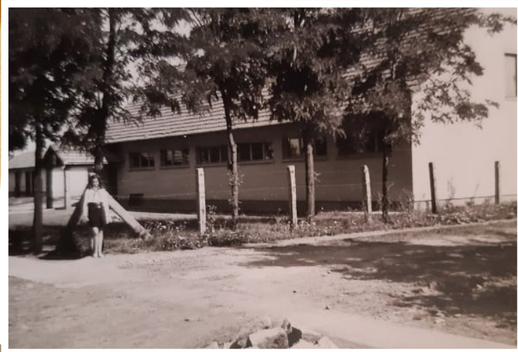
Általános iskola épül 1950-ben
