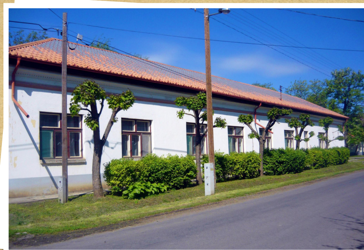
Nagy iskola épülete
