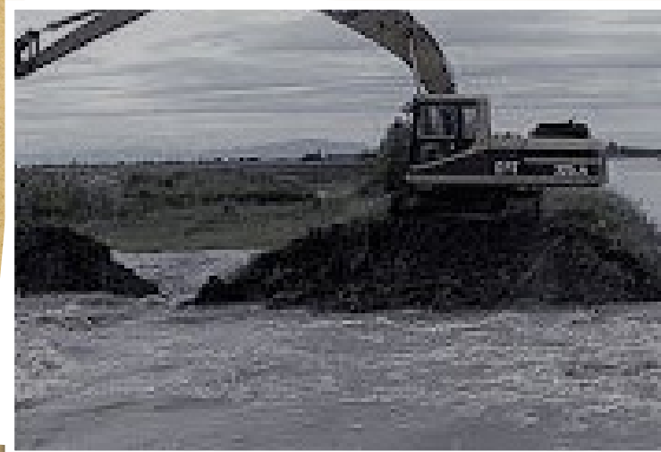
Nagykunsági Öntöző Főcsatorna építése településünk határában
