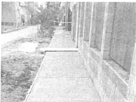
XV. utca járda javítás, új járda építése
