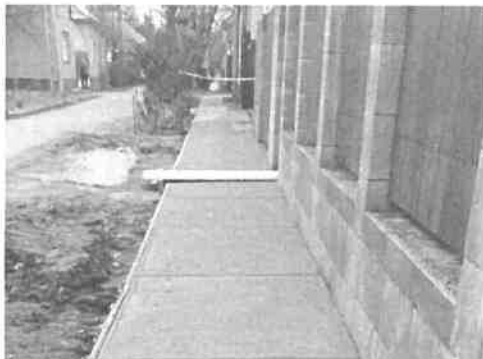
XV. utca járda javítás, új járda építése
