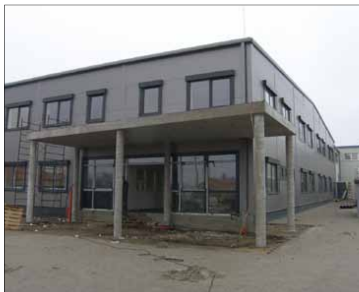
A RAFI HUNGÁRIA KFT. ÉPÜLŐ ÚJ CSARNOKA
