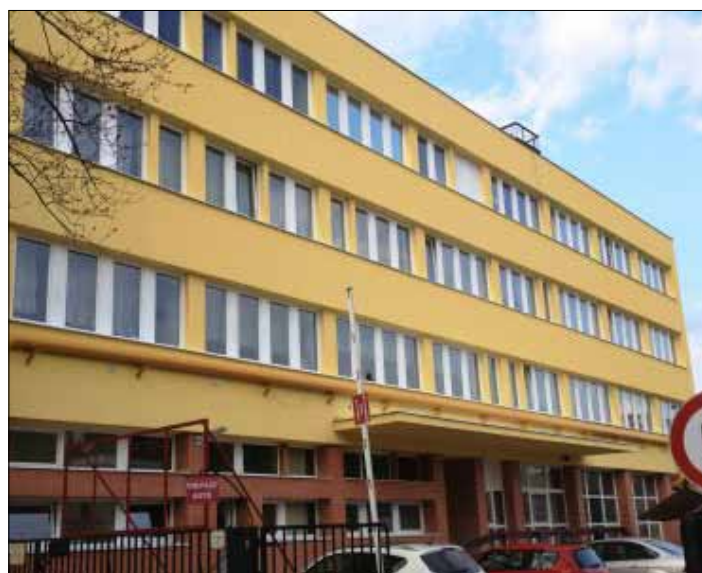
A MEZŐTÚRI KÓRHÁZ ÉS RENDELŐINTÉZET FELÚJÍTOTT HOMLOKZATA
